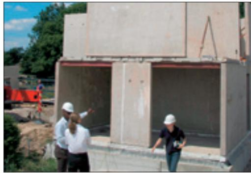
Vom Wohnsilo zum Einfamilienhaus: Nach dem Abriss werden die Betonplatten neu gefügt und die Kanten ausgegossen.
