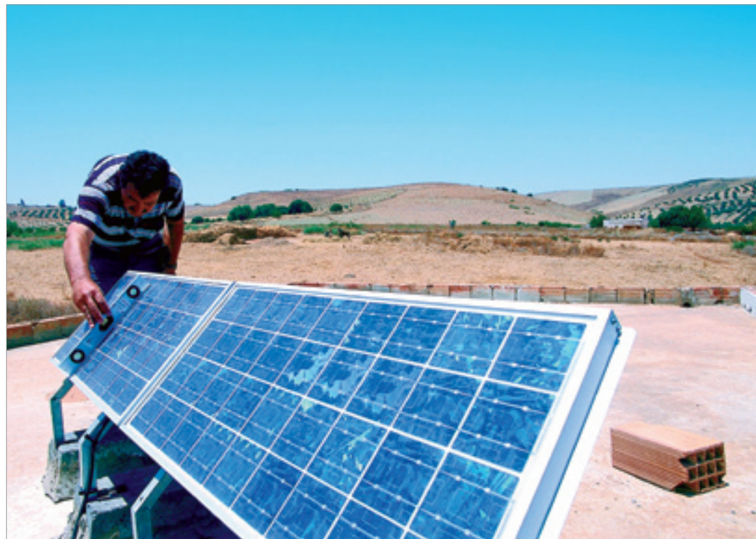
Marokkanischer Techniker prüft eine Solaranlage nach dem Aufbau.
