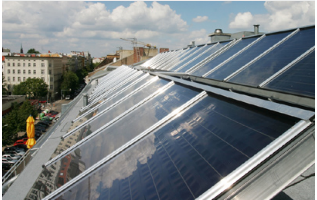
Anlage zur Erzeugung von Sonnenwärme auf einem Haus in Prenzlauer Berg, Berlin.
