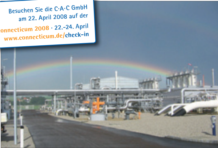
Erdgasuntergrundspeicher Haidach / Salzburg, Oberösterreich 2007
