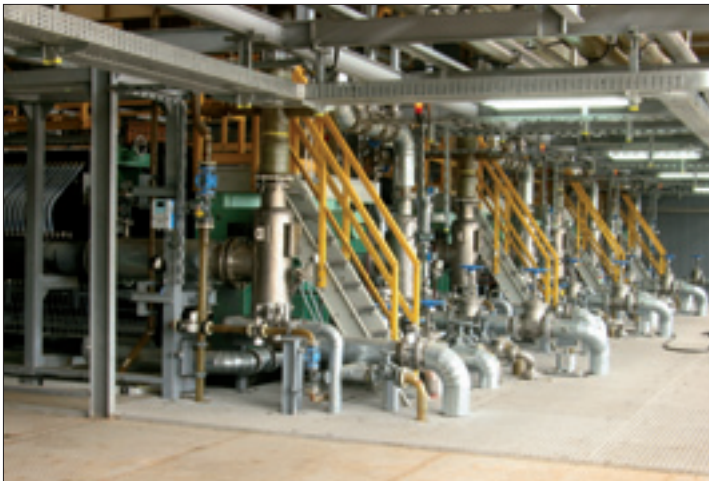
Chloralkalielektrolyse in Sajansk 2007
